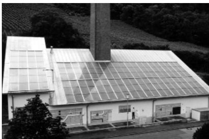
Abb. IV-12.5: Hegau-Klinikum Singen GmbH, Kollektorfläche 264 m², Im Probebetrieb
