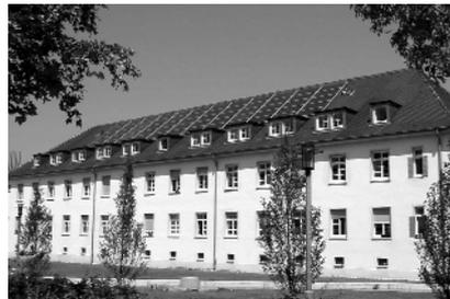
Abb. IV-12.3: Studentendorf Vauban in Freiburg, Kollektorfläche 143 m², Detailmessbetrieb abgeschlossen
