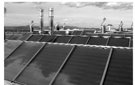
Abb. IV-12.7: Wohngebäude Wilmersdorfer Str. Freiburg, Kollektorfläche 228 m², Probebetrieb ab Januar 2001
