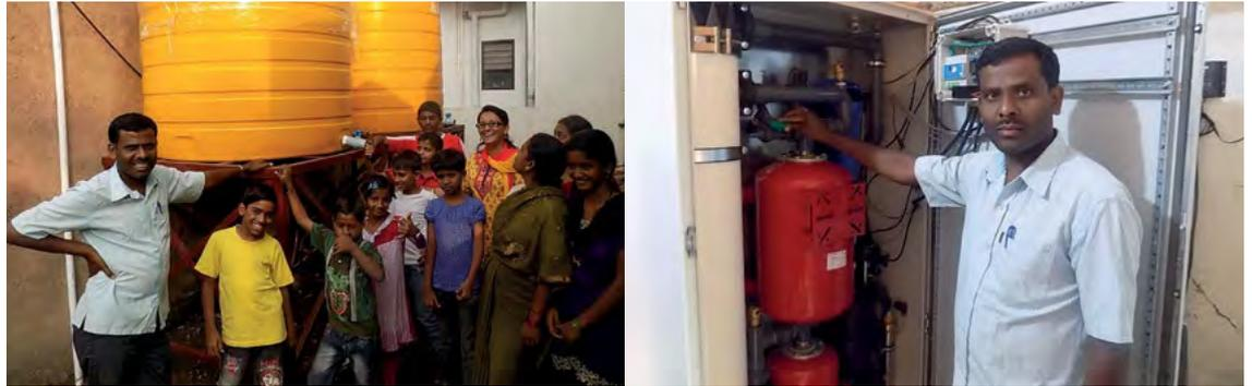
Abb. 4: (links) Speisewasser- und Filtrattank, (rechts) Ultrafiltrationsanlage mit Datenfernübertragung in Belgaum, Indien
