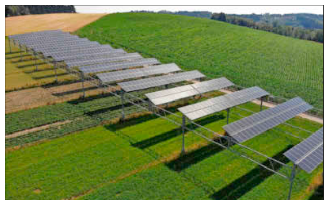
Eine Agrofotovoltaikanlage könnte auf dem Feld von Georg Hosch errichtet werden. Unter den Solarpaneelen können Landmaschinen fahren. Diese Anlage steht in Heggelbach am Bodensee.
