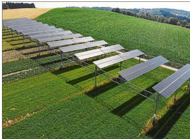
So könnte eine Agrofotovoltaik-Anlage in Neuried aussehen: In Heggelbach am Bodensee befindet sich bereits ein solcher Aufbau seit einigen Jahren im Testbetrieb. Unter den Gestellen passen immer noch Landmaschinen hindurch. Foto: BayWa r.e.
